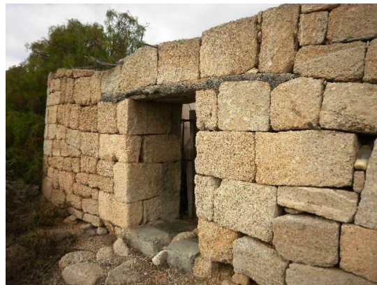
Mur (antic) de pedra tosca.
